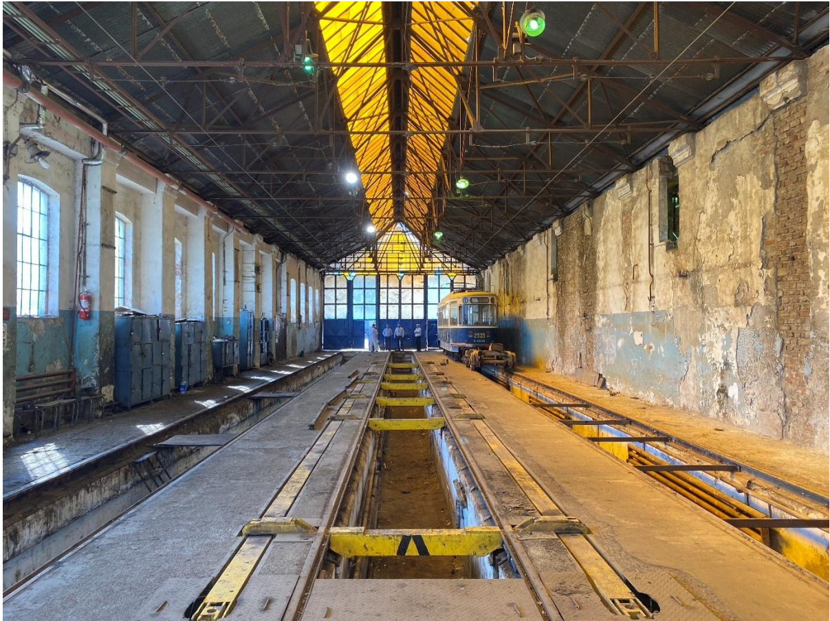
Imagine din interiorul unei hale a depoului. Sursă: Iulian Canov, ADIZMB
