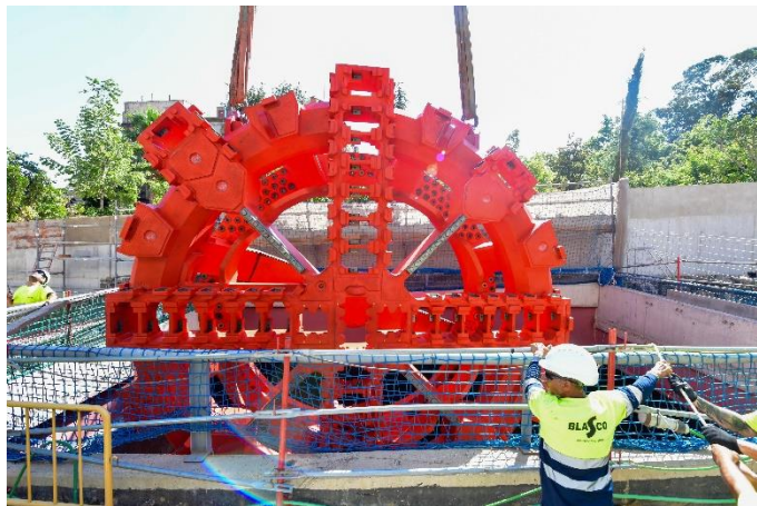
Descens peça central nova de roda de tall
