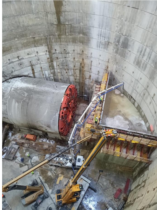
Muntatge roda de tall i execució dau de formigó
