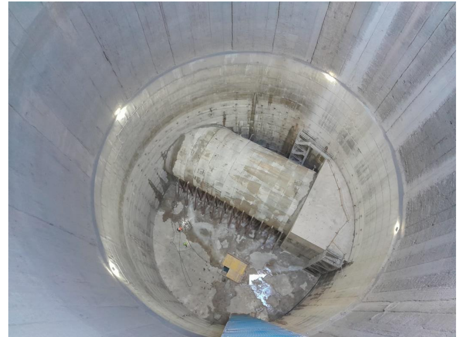
Represa excavació túnel Mandri - Lesseps
