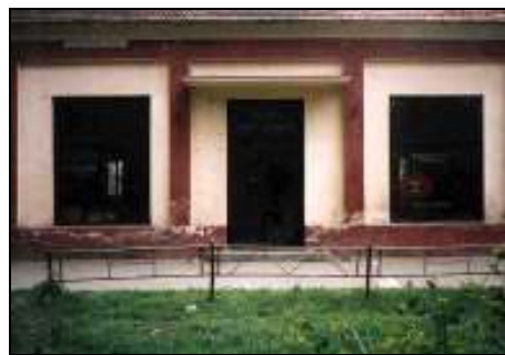
Clădirea fostei Agenții de voiaj C.F.R..
