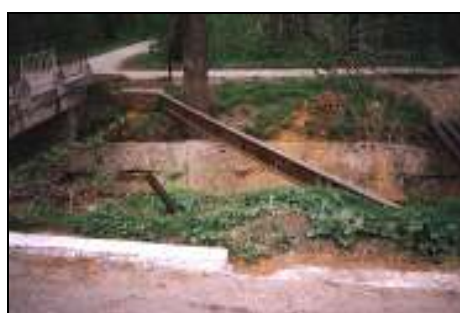
Grinda metalică a vechiului pod.
