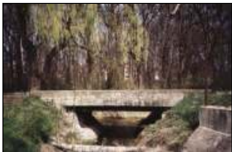
Pod rutier construit pe grinzile metalice ale fostului pod feroviar.
