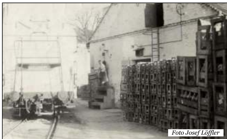
Vagon termoizolant pe linia de garare din incinta Apeminului în anii '60.
