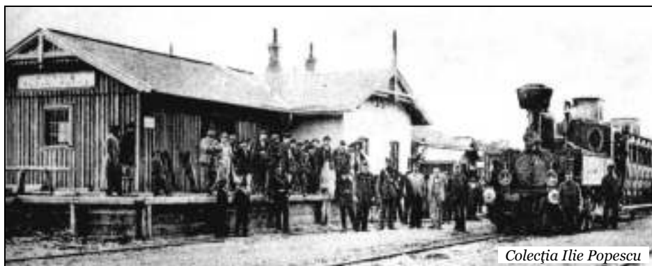
Locomotiva 97.120, tip Ct-n2, construită de Krauss, Linz – 1897, în gara Putna în anul 1909.
