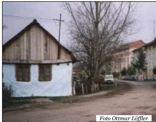
Casa și curtea fostului revizor de cale, Olacsy.
