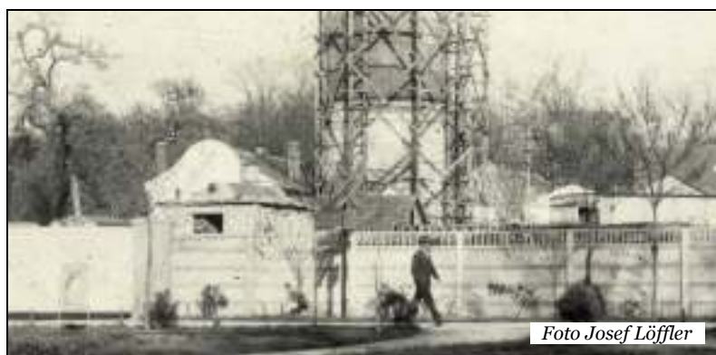
Poarta din spatele Apeminului. În stânga se observă acoperișurile vagoanelor termoizolante și clădirea gării Buziaș Băi.
