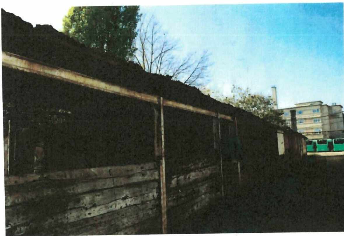
Fig. 6 Șopron (C29): Vedere exterioară de ansamblu
