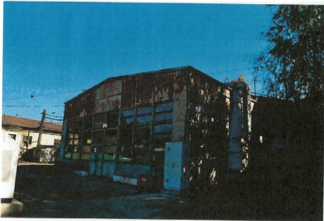
Fig. 1 C28- Atelier intretinere 11,Atelier turnatorie (C28): Vedere exterioră asupra structurii metalice
