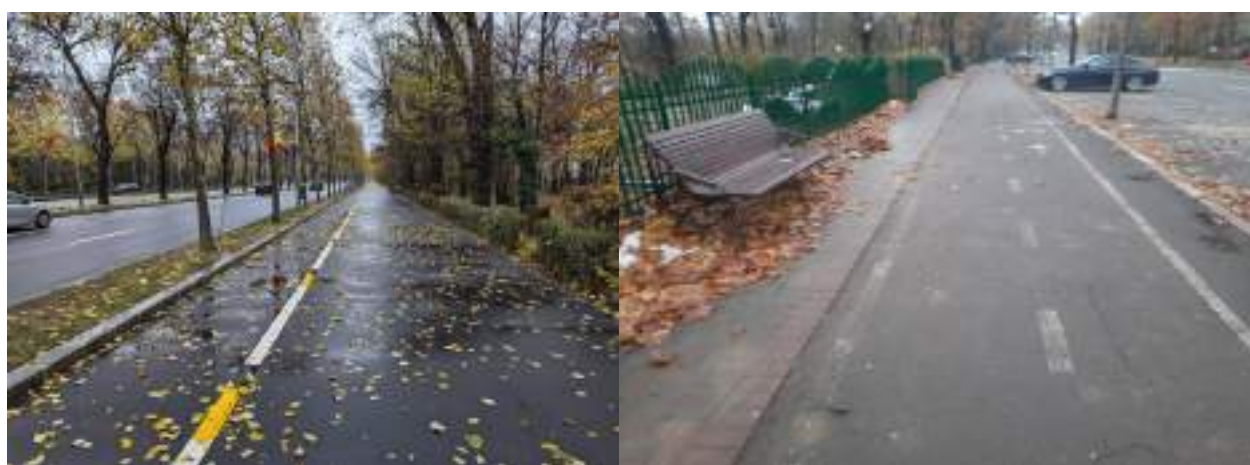
Sursa: Arhiva autorilor (2023). Stânga: pistă pe trotuar cu spațiu pentru pietoni, bd. Regele Mihai I. Dreapta: pistă pe trotuar fără spațiu pentru pietoni, strada Constantin Brâncuși.
