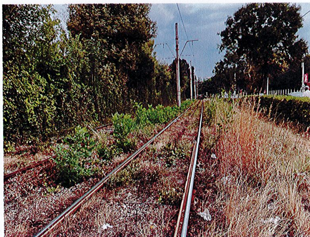
Foto 12 Strada Petricani – stația Șoseaua Fabrica de Glucoză
