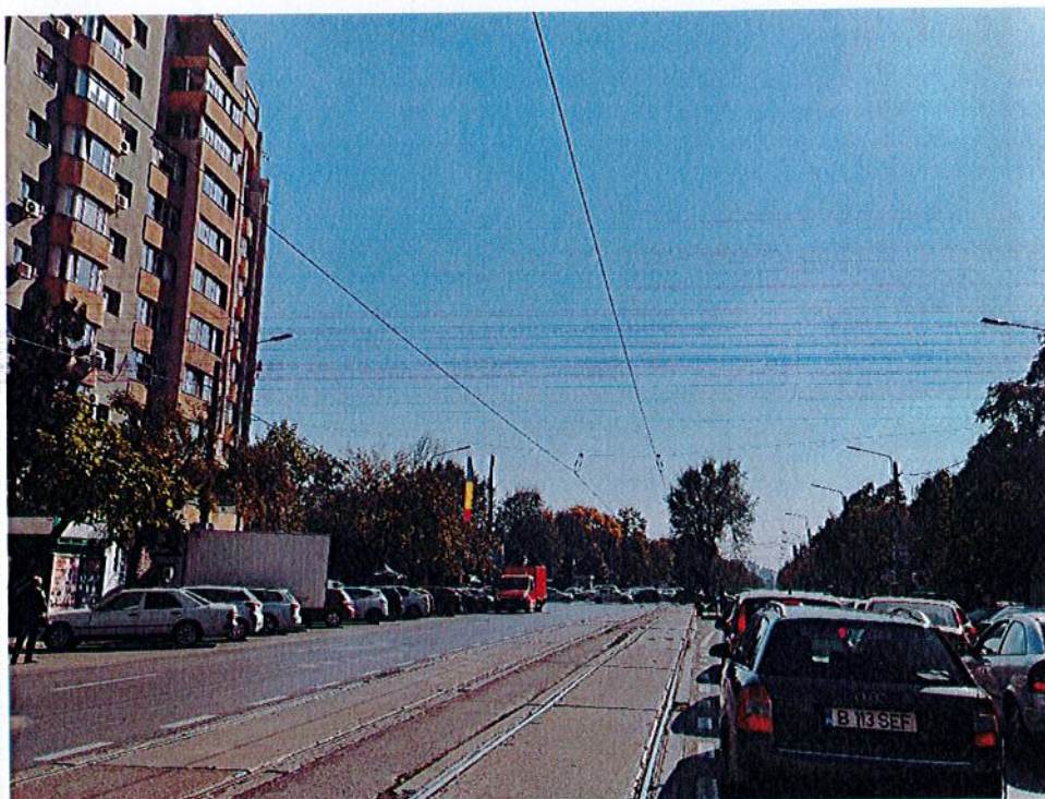
Foto 55 Bulevardul Chișinău – spre intersecție cu Bulervadul Basarabia
