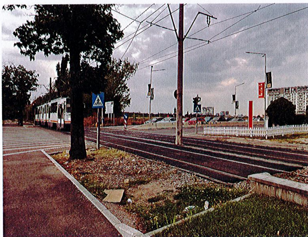
Foto 8 Strada Petricani – zona intersecție cu A3 spre Fabrica de Glucoză
