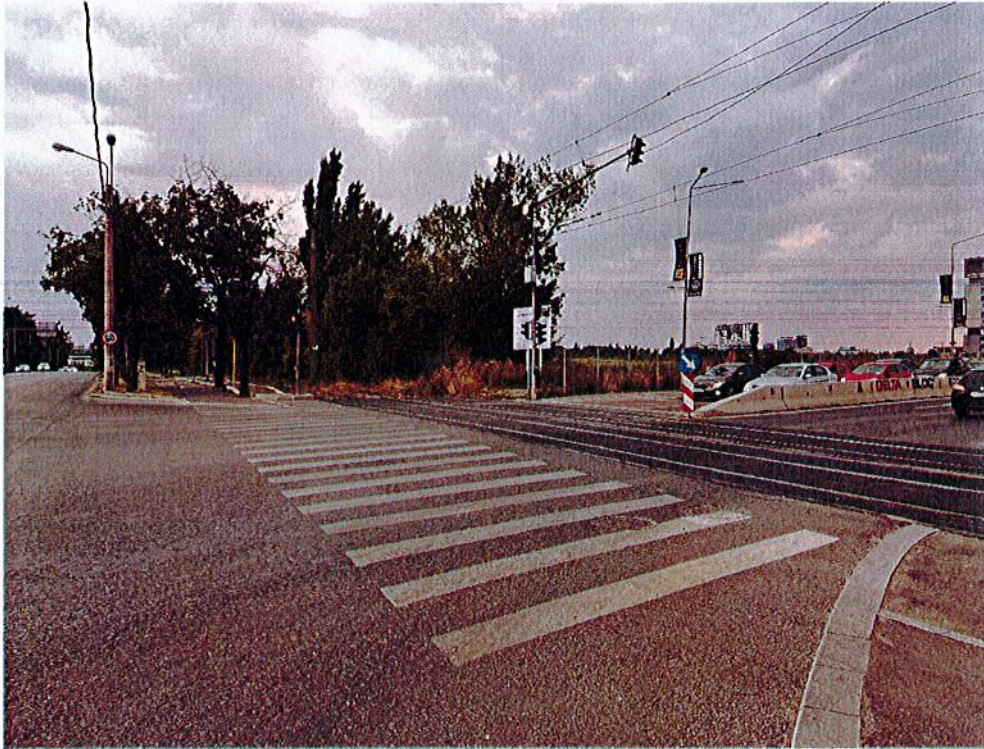
Foto 9 Strada Petricani – zona intersecție cu A3 spre Fabrica de Glucoză
