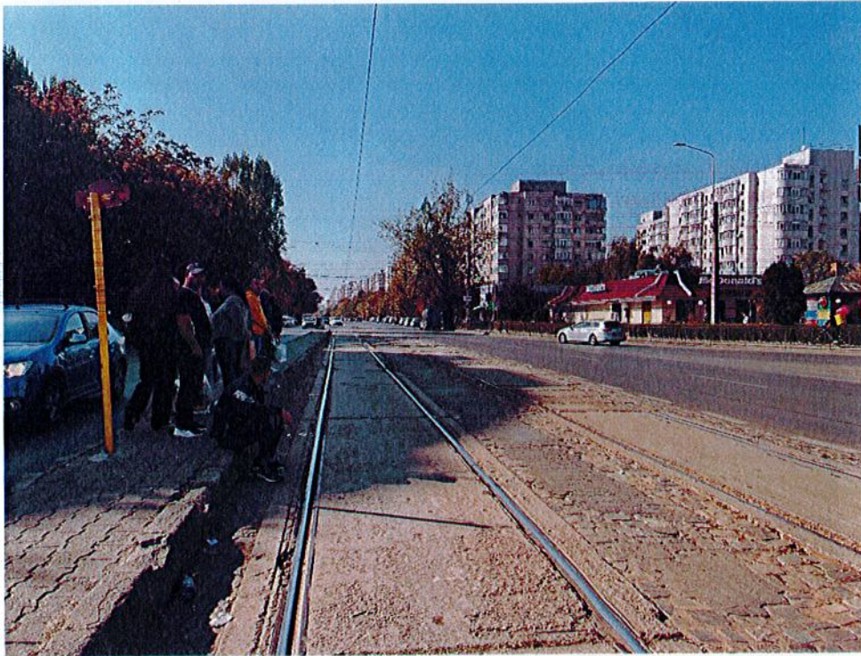
Foto 59 Stația Lucrețiu Pătrășcanu
