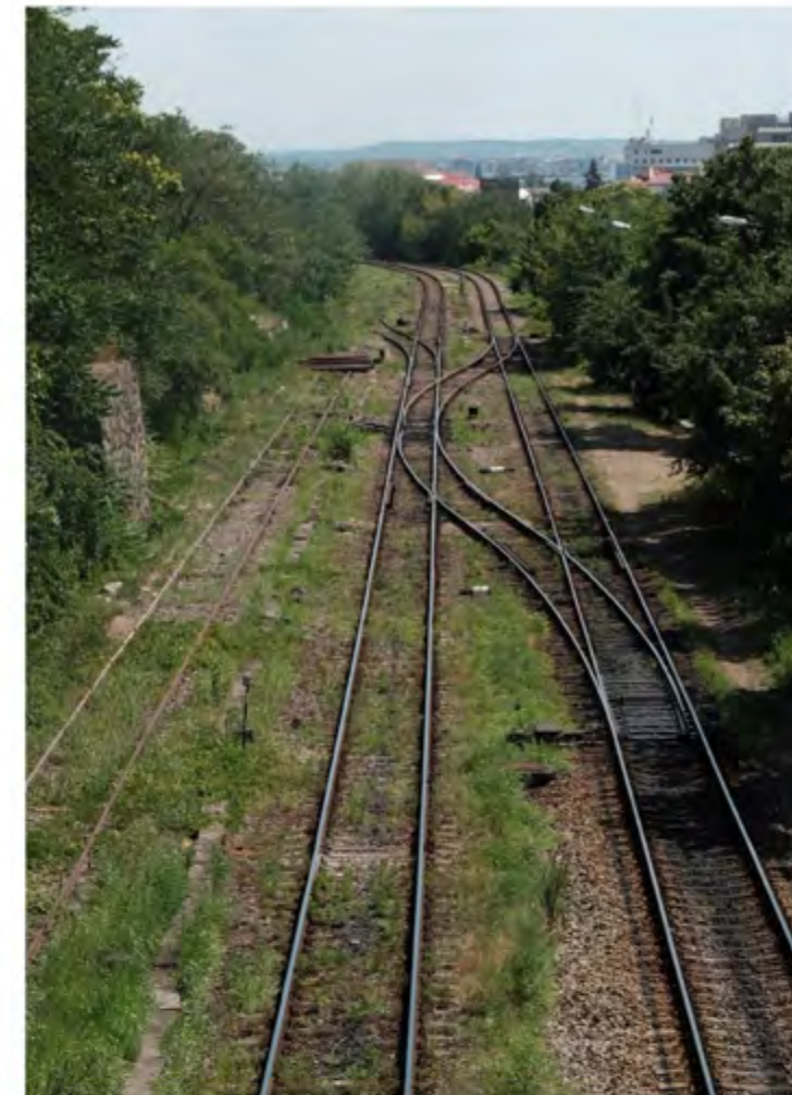
VEDERE ÎN LUNGUL CĂII FERATE DE PE PASARELA DIN STRADA PESCĂRUȘULUI
