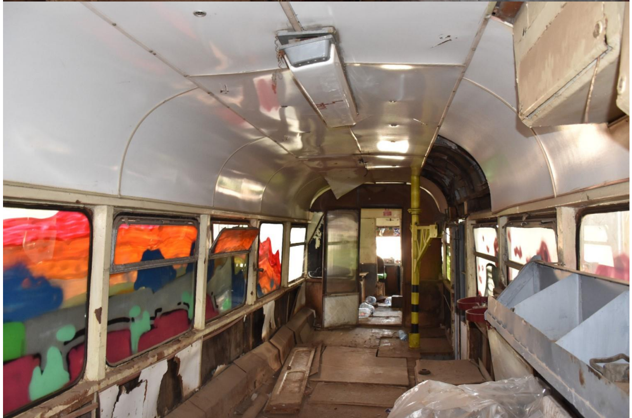
6133 – interiorul, în condiție slabă de preservare.
