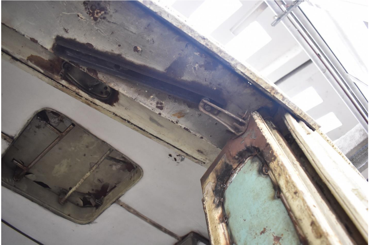
6090 – exteriorul, detaliu al ușii 3.
