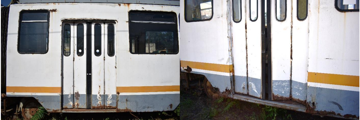
4042 – exterior, detalii uși. Ușile s-au gripat în cei 10 ani, astfel că membrii Asociației „Metrou Ușor” nu au putut fotografia și înăuntru. Se remarcă urme de coroziune accentuată.
