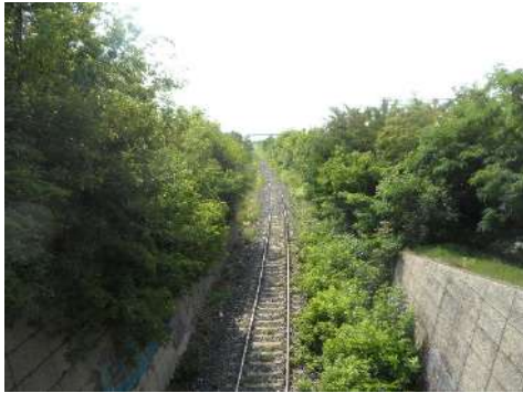
Zona tunel km ex. 7+931
