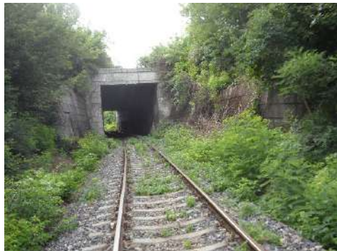
Zona tunel km ex. 7+931
