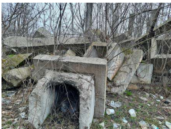
Blocuri de beton abandonate
