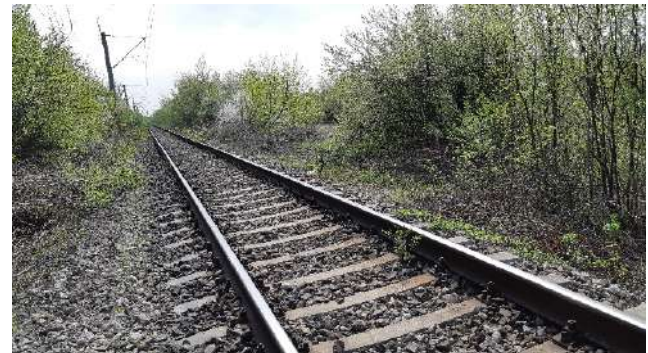
Zona tunel km ex. 7+931
