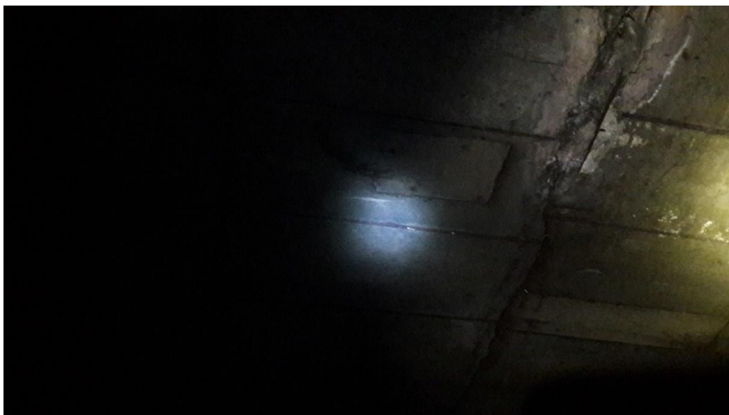
Fotografia 1 – Prima urmă de lovire a pantografului pe planșeu, între Politehnica și Eroilor, km 0+844
