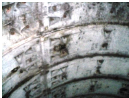
Infiltrații prin rosturi transversale în bolta inelelor 1115 și 1140. Se etanșează cu rășină hidrostructurală cu vâscozitate redusă
