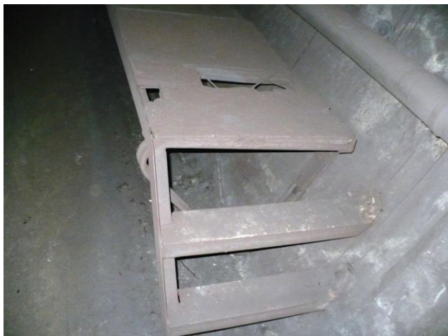
Banchetă metalică de circulație între inelele 1375 și 1010 (365m)
