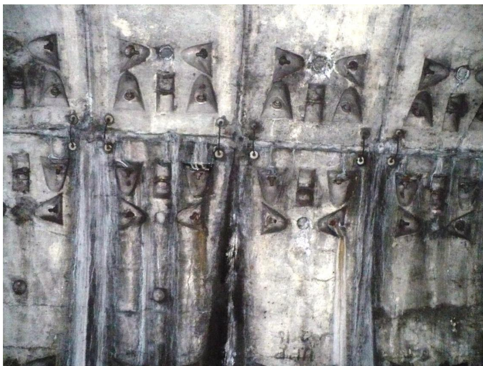
Infiltrații în zona inelului 665, la rostul dintre bolțarii din boltă
