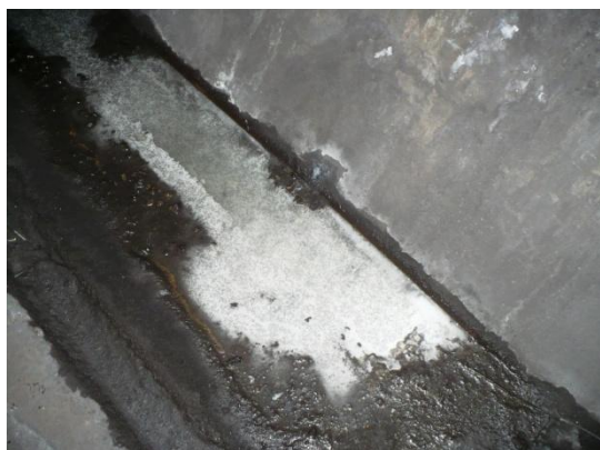
Infiltrații la rostul dintre fundația de cale și tunel, între inelele 271÷290;
