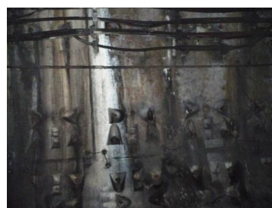
Infiltrații în rosturile dintre bolțari, în zona inelului 788. Este necesară etanșarea prin injectare cu rășină hidrostructurală cu vâscozitate redusă
