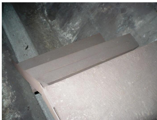
Banchetă metalică de circulație între inelele 975 și 845 (130m)
