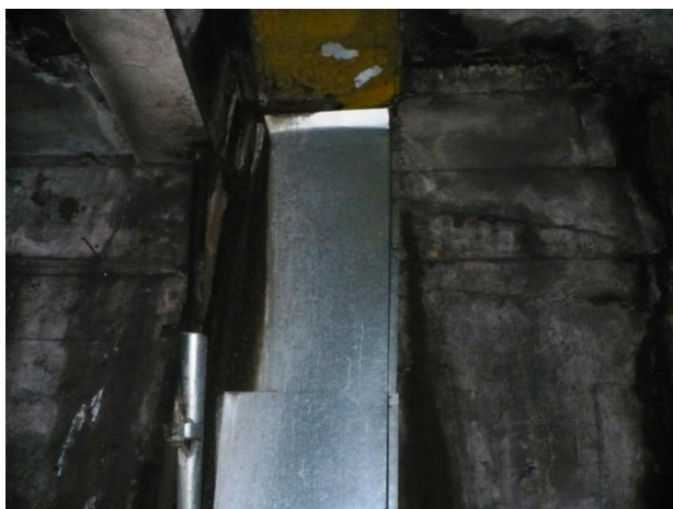
Infiltrații prin structura zonei de ieșire din stație, acoperite cu tablă pentru protecția căii de rulare
