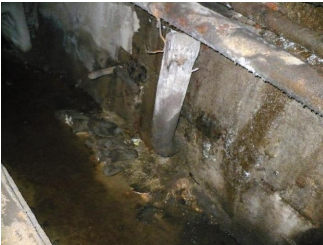
Lipsă continuitate rigolă prefabricată pentru dirijarea apelor de infiltrație, rigolă folosită și pentru circulația pietonală
