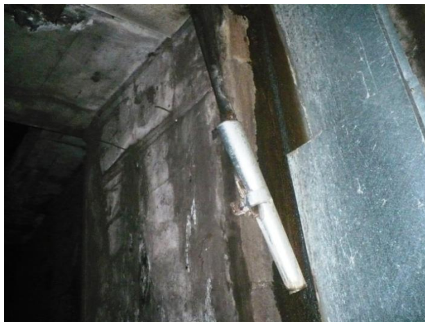
Infiltrații prin structura zonei de ieșire din stație, acoperite cu tablă pentru protecția căii de rulare
