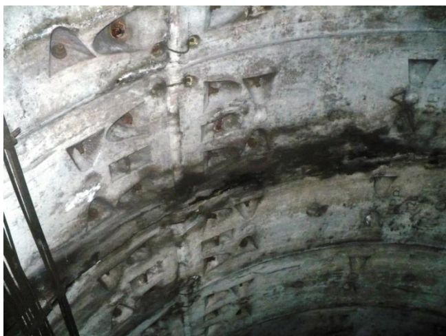
Infiltrații prin rosturi transversale, la inelul 555.
