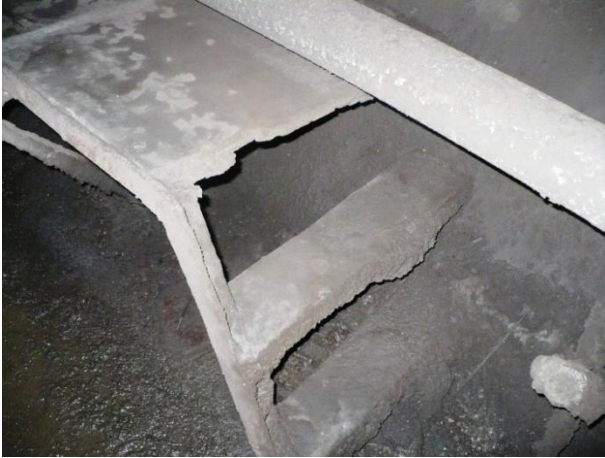
Zonă cu banchetă de circulație, între inelele 5÷290 (285m). Se va demonta și se va executa și monta o banchetă nouă
