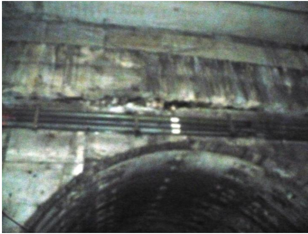
Infiltrații între peretele de fronton al stației și tunel (inel 1). Se etanșează cu rășină hidrostructurală cu vâscozitate redusă
