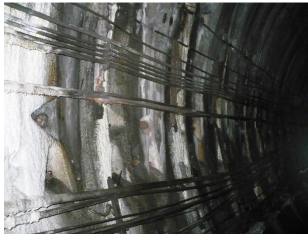
Infiltrații prin rosturile dintre bolțari, între inelele 452÷480. Este necesară etanșarea prin injectare cu rășină hidrostructurală cu vâscozitate redusă, infiltrațiile ajungând în zona căii de rulare, ca urmare a presiunii existente în lungul fisurilor din bolțari
