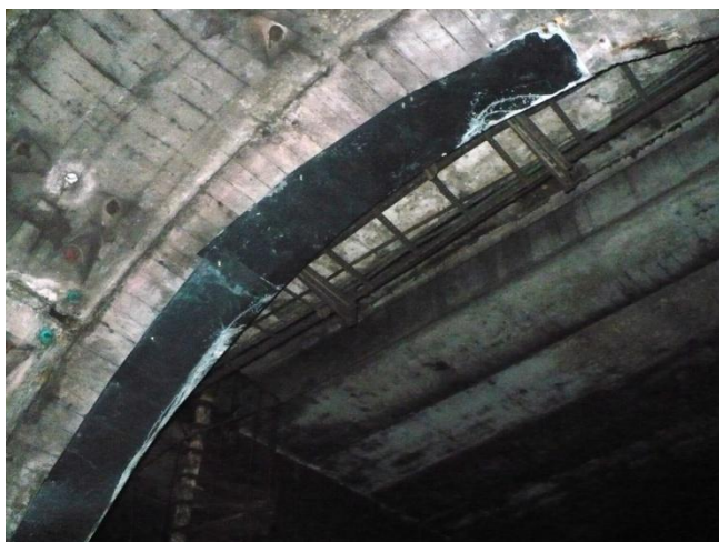
Infiltrații la legătura tunelului cu structura PLS-ului, zone acoperite cu tablă pentru protecția căii de rulare
