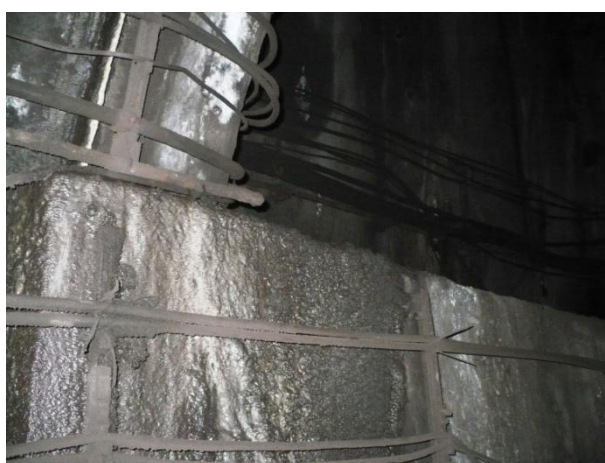
Infiltrații prin bolta tunelului din zona stației de pompare de pe interstație, și lateral, prin zona betonată a acesteia (zona inelului 610). Se etanșează cu rășină hidrostructurală cu vâscozitate redusă
