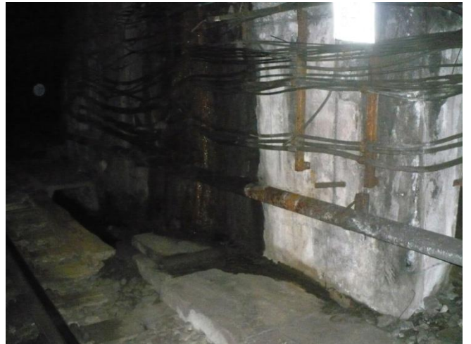
Lipsă continuitate rigolă prefabricată pentru dirijarea apelor de infiltrație, rigolă folosită și pentru circulația pietonală
