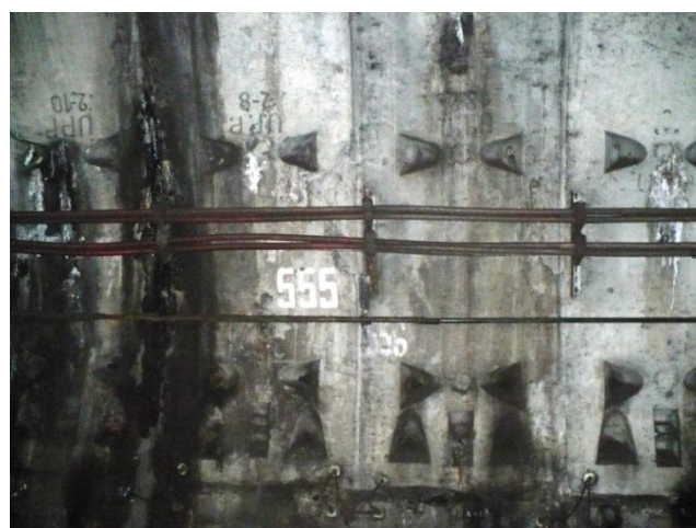
Infiltrații prin rosturi transversale, la inelul 555.
