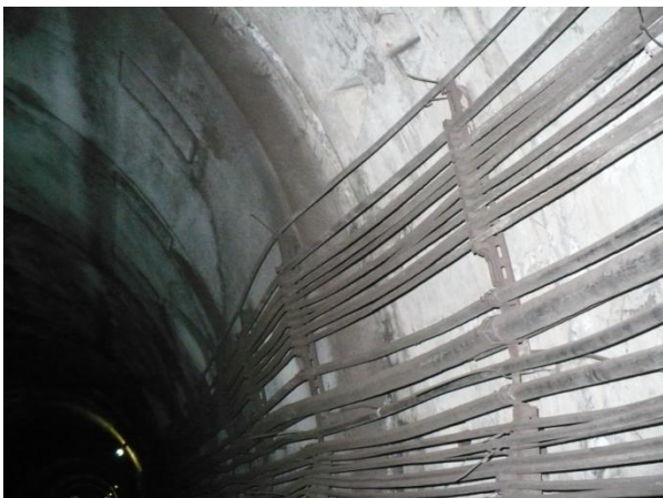
Infiltrații, pe conturul inelului secundar (realizat pentru protecția zonei de subtraversare a râului Dâmbovița, în lungime de 60m)
