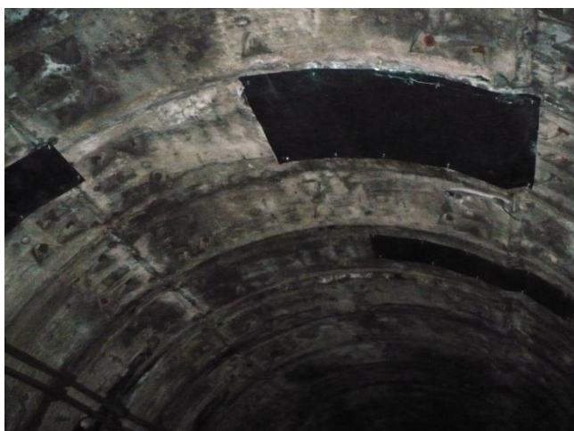
Infiltrații în bolta tunelului (acoperite cu tablă) și pe lateral, în zona inelului 240
