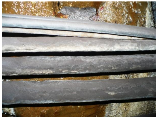
Infiltrații cu aport de nisip, la inelul 135.
