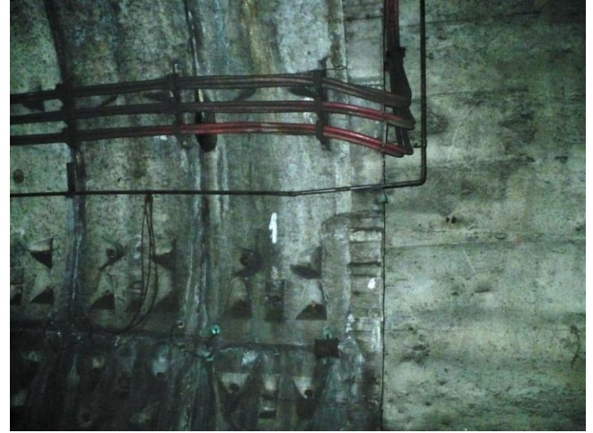
Infiltrații între peretele de fronton al stației și tunel (inel 1). Se etanșează cu rășină hidrostructurală cu vâscozitate redusă
