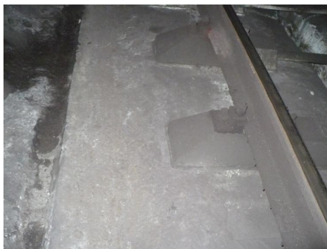
Denivelare între bancheta de circulație și betonul de monolitizare. Se reconformează zona, după montarea noilor blocheți
