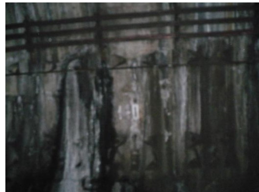
Infiltrații prin găuri de buloane și rosturi transversale între inelele 35÷110 Se etanșează cu rășină poliuretanică (găurile de buloane), respectiv rășină hidrostructurală cu vâscozitate redusă (la rosturi)
