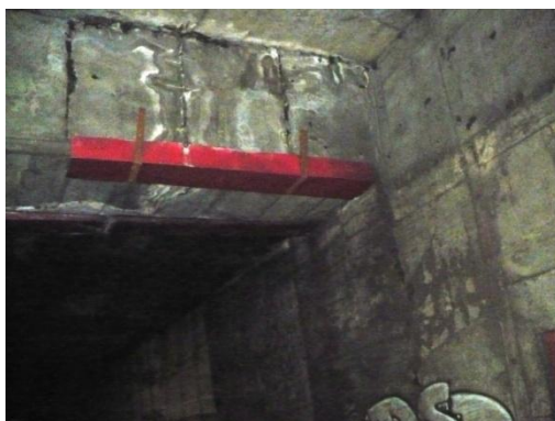
Infiltrații prin structura stației, în zona de detentă, acoperită cu jgheaburi din tablă. Se etanșează zonele cu rășină poliuretanică
