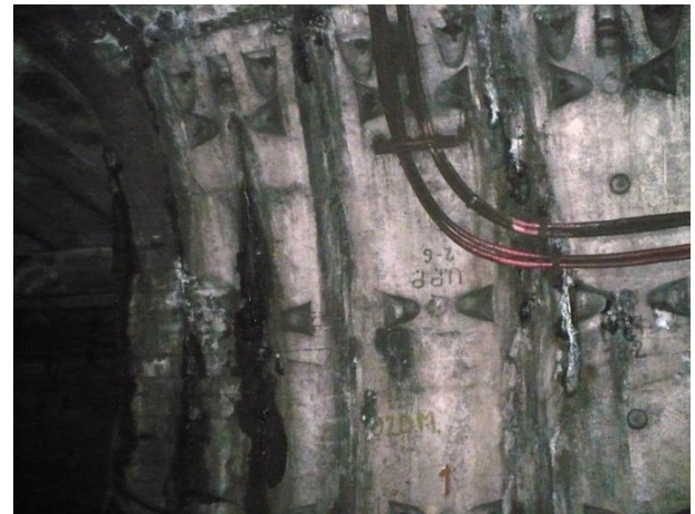
Infiltrații în boltă și pe lateral, la legătura inelului 1 cu peretele casetă al stației
