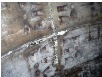
Infiltrații în rosturile dintre bolțari, în zona inelului 788. Este necesară etanșarea prin injectare cu rășină hidrostructurală cu vâscozitate redusă
