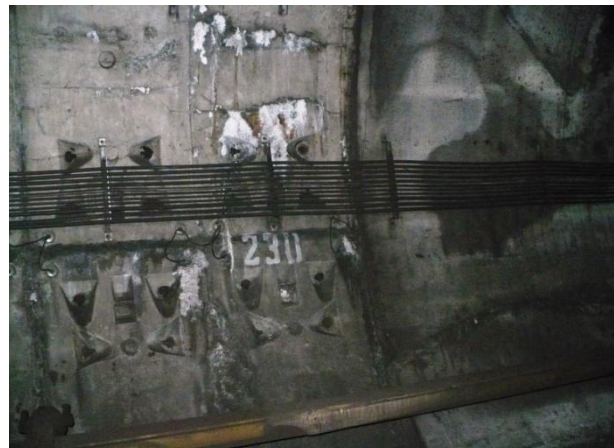
Infiltrații, pe conturul inelului secundar (realizat pentru protecția zonei de subtraversare a râului Dâmbovița, în lungime de 60m)
