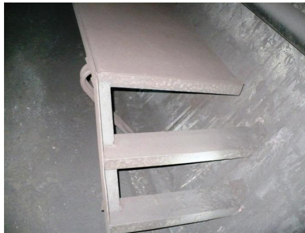
Banchetă metalică de circulație între inelele 700 și 880 (180m)
