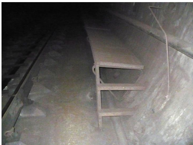
Banchetă metalică de circulație între inelele 170 și 275 (105m)
