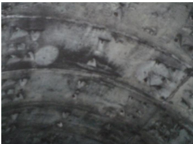
Infiltrații în zona bolții, la inelele 805, respectiv 785. Se etanșează prin injectare cu rășină poliuretanică
