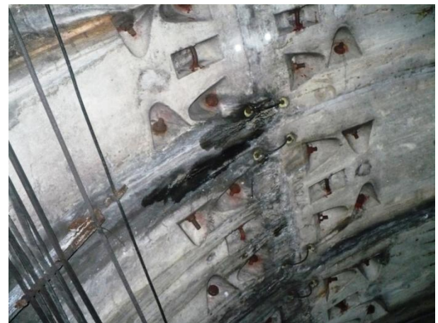
Infiltrații la rostul transversal din bolta tunelului, la inel 895. Se etanșează cu rășină hidrostructurală cu vâscozitate redusă
