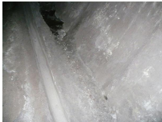
Infiltrații la rostul dintre fundația de cale și tunel, între inelele 271÷290;
