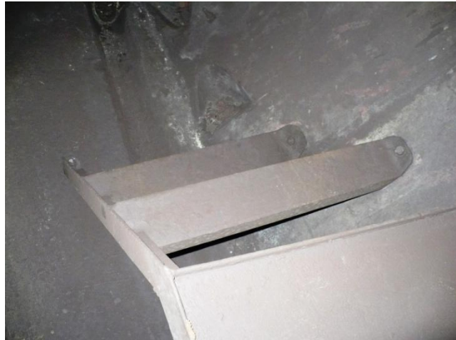
Banchetă metalică de circulație între inelele 170 și 275 (105m)
