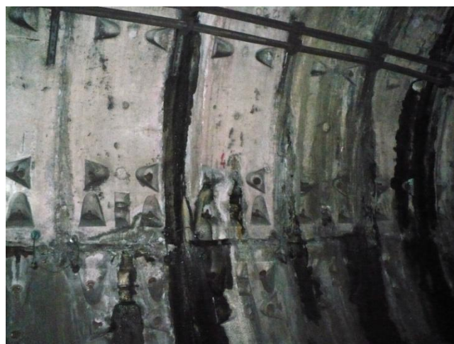
Infiltrații în bolta tunelului (acoperite cu tablă) și pe lateral, în zona inelului 240
