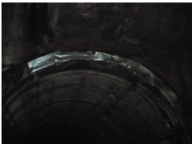
Infiltrații prin bolta tunelului din zona stației de pompare de pe interstație, și lateral, prin zona betonată a acesteia (zona inelului 610). Se etanșează cu rășină hidrostructurală cu vâscozitate redusă
