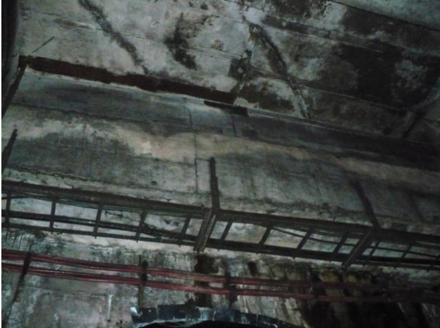
Infiltrații cu debit mare în zona PLS Bibescu Vodă
