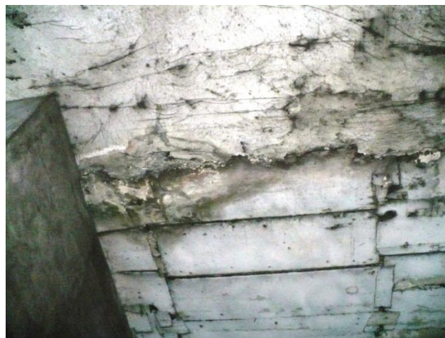
Infiltrații prin vuta dintre planșeu și peretele casetă, prin fisura existentă în planșeu și în zona de legătură cu detenta stației, prin tavan, pe firul 2 de circulație
