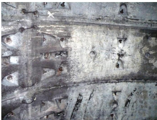
Similar, la inelul 765. Se etanșează prin injectare cu rășină poliuretanică
