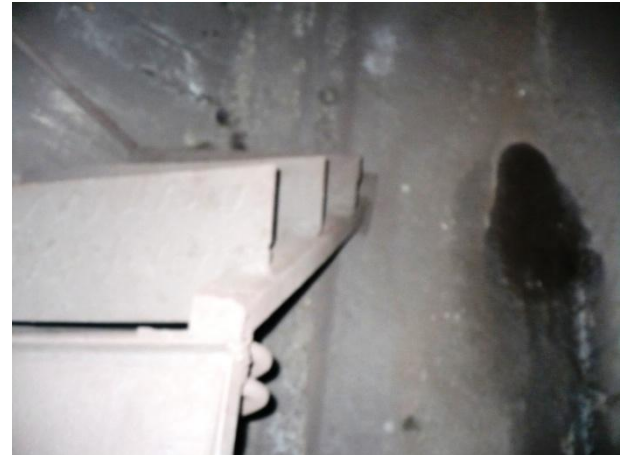
Banchetă de circulație metalică între inelele 80÷220 (140m). Se va demonta și se va executa și monta o banchetă nouă
