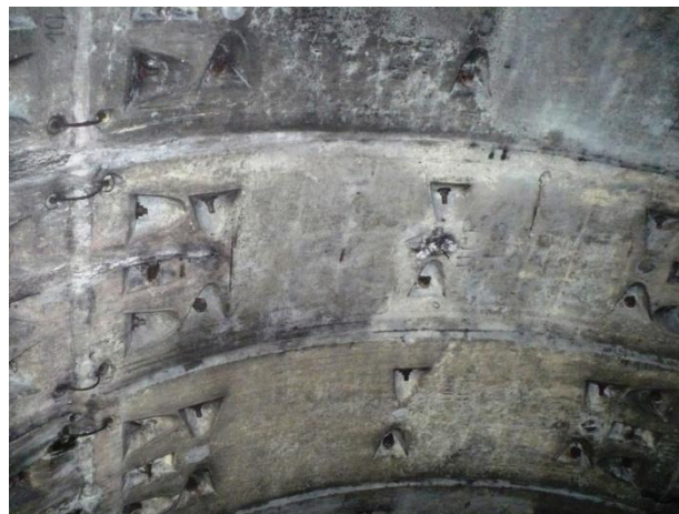
Similar, la inelul 765. Se etanșează prin injectare cu rășină poliuretanică
