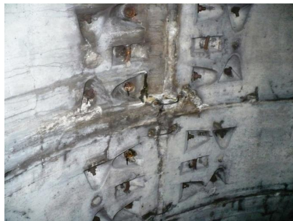
Infiltrații în bolta tunelului de la inelele 554 și 565, prin rosturile dintre boltari. Se etanșează prin injectare cu rășină hidrostructurală cu vâscozitate redusă
