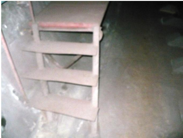
Banchetă de circulație metalică între inelele 80÷220 (140m). Se va demonta și se va executa și monta o banchetă nouă
