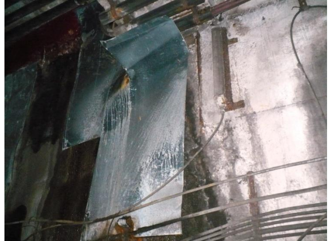
Infiltrații cu debit mare în zona PLS Bibescu Vodă
