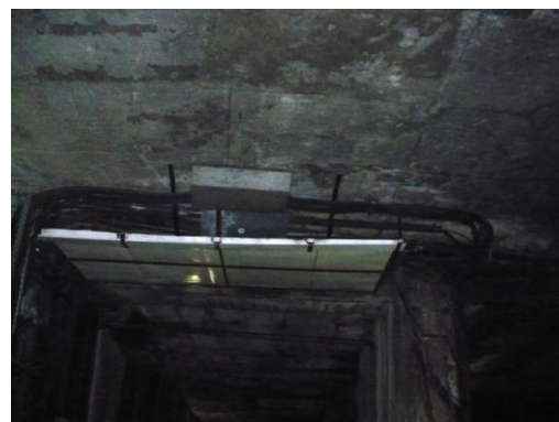
Infiltrații prin structura stației, în zona de detentă, acoperită cu jgheaburi din tablă. Se etanșează zonele cu rășină poliuretanică
