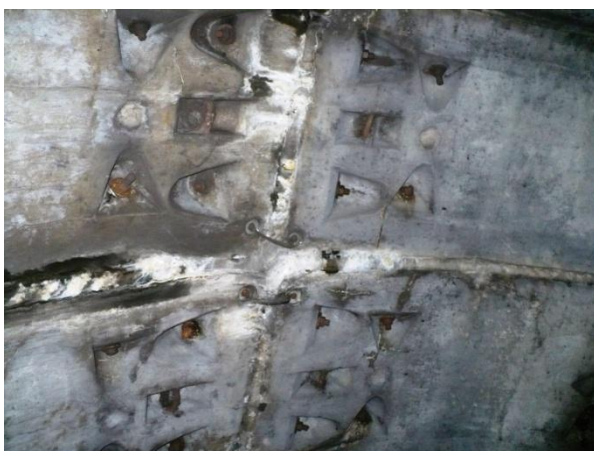
Infiltrații în bolta tunelului de la inelele 554 și 565, prin rosturile dintre boltari. Se etanșează prin injectare cu rășină hidrostructurală cu vâscozitate redusă
