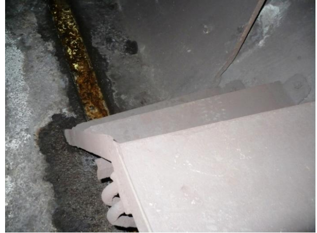
Zonă cu banchetă de circulație, între inelele 5÷290 (285m). Se va demonta și se va executa și monta o banchetă nouă
