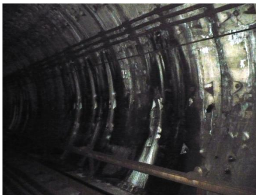
Infiltrații prin găuri de buloane și rosturi transversale între inelele 35÷110 Se etanșează cu rășină poliuretanică (găurile de buloane), respectiv rășină hidrostructurală cu vâscozitate redusă (la rosturi)
