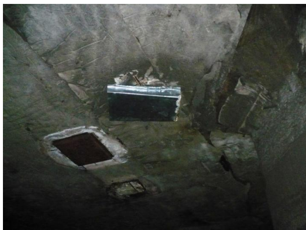
Infiltrații prin zone fisurate ale planșului, acoperite cu tablă, pentru protecția căii de rulare. Se etanșează zonele cu rășină poliuretanică
