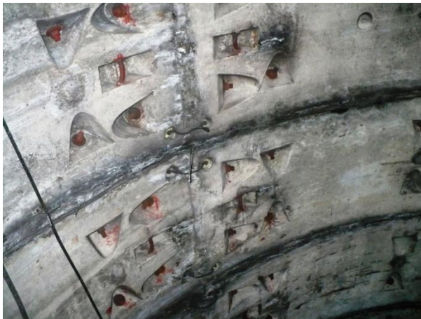
Infiltrații la rostul transversal din bolta tunelului, la inel 895. Se etanșează cu rășină hidrostructurală cu vâscozitate redusă
