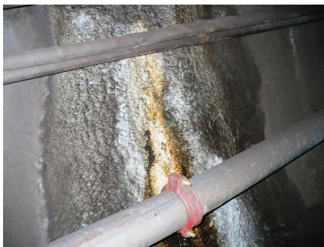
Similar, la inelul 415, prin gaură de injectare primară. Se etanșează prin injectare cu rășină hidrostructurală cu vâscozitate redusă
