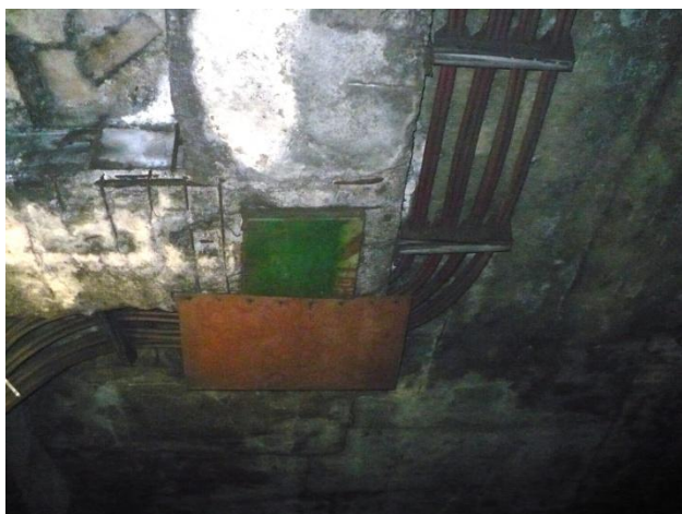
Infiltrații prin zone fisurate ale planșului, acoperite cu tablă, pentru protecția căii de rulare. Se etanșează zonele cu rășină poliuretanică
