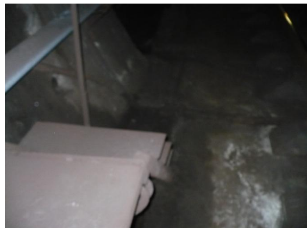
Banchetă de circulație metalică între inelele 860÷1090 (230m) Se va demonta și se va executa și monta o banchetă nouă
