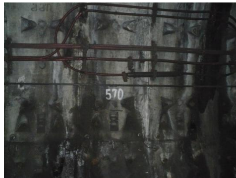
Packer rămas în bolta inelului 570 (care trebuie scos).
