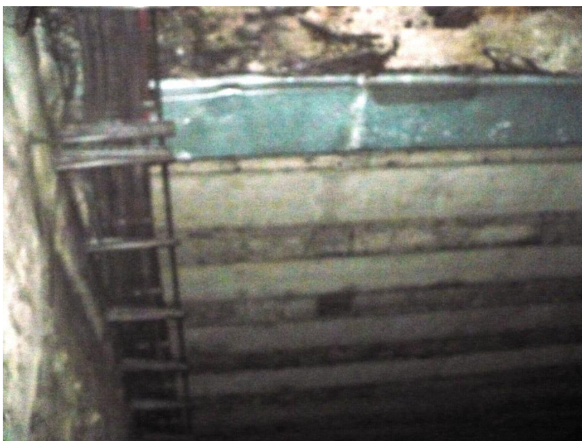
Similar, pe linia 1 Se etanșează cu rășină hidrostructurală cu vâscozitate redusă
