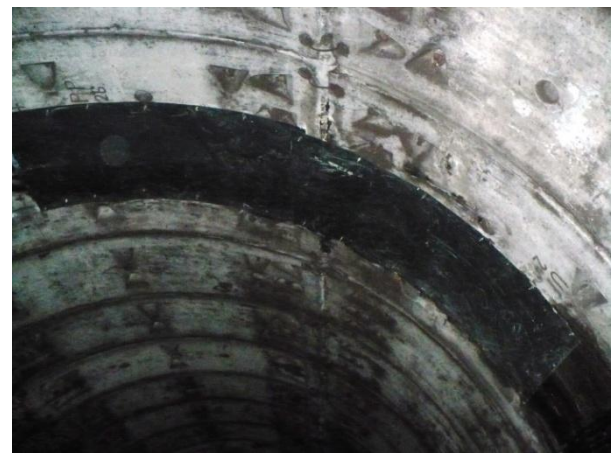
Infiltrații din bolta tunelului, acoperite cu tablă, în zona inelului 415
