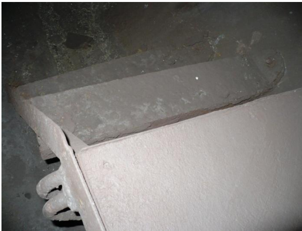
Banchetă metalică de circulație între inelele 700 și 880 (180m)
