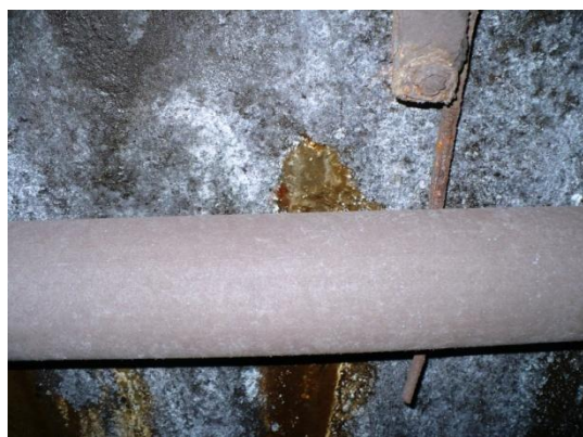
Infiltrații cu aport de nisip, la inelul 135.
