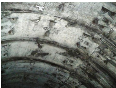
Packer rămas în bolta inelului 570 (care trebuie scos).
