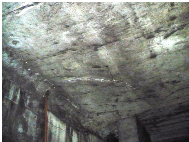
Infiltrații prin vuta dintre planșeu și peretele casetă, prin fisura existentă în planșeu și în zona de legătură cu detenta stației, prin tavan, pe firul 2 de circulație
