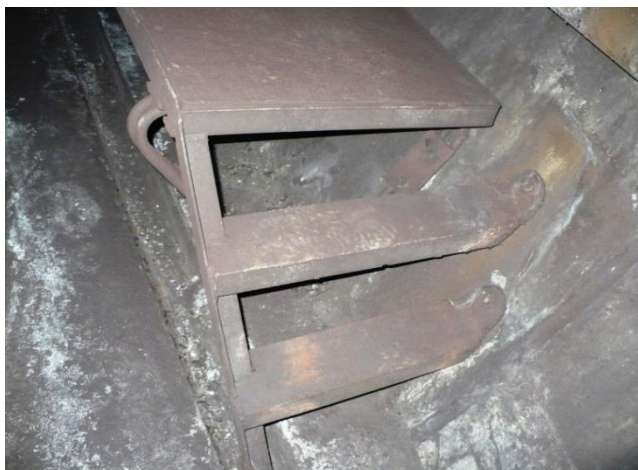
Banchetă metalică de circulație între inelele 975 și 845 (130m)
