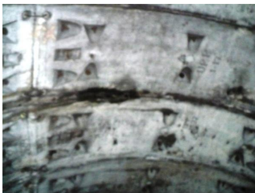
Infiltrații prin rosturi transversale în bolta inelelor 1115 și 1140. Se etanșează cu rășină hidrostructurală cu vâscozitate redusă
