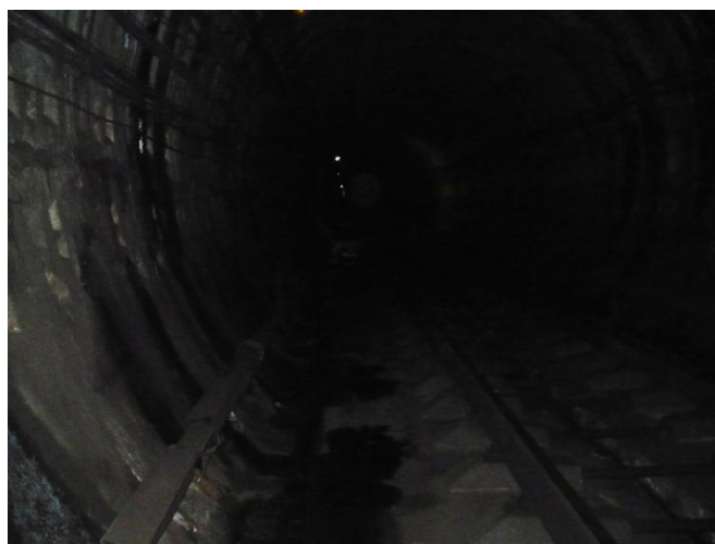
Infiltrații prin fundația de cale, între inelele 405÷425 (21m). Este necesară demoalrea fundației de cale, etanșarea vetrei tunelului și refacerea fundației
