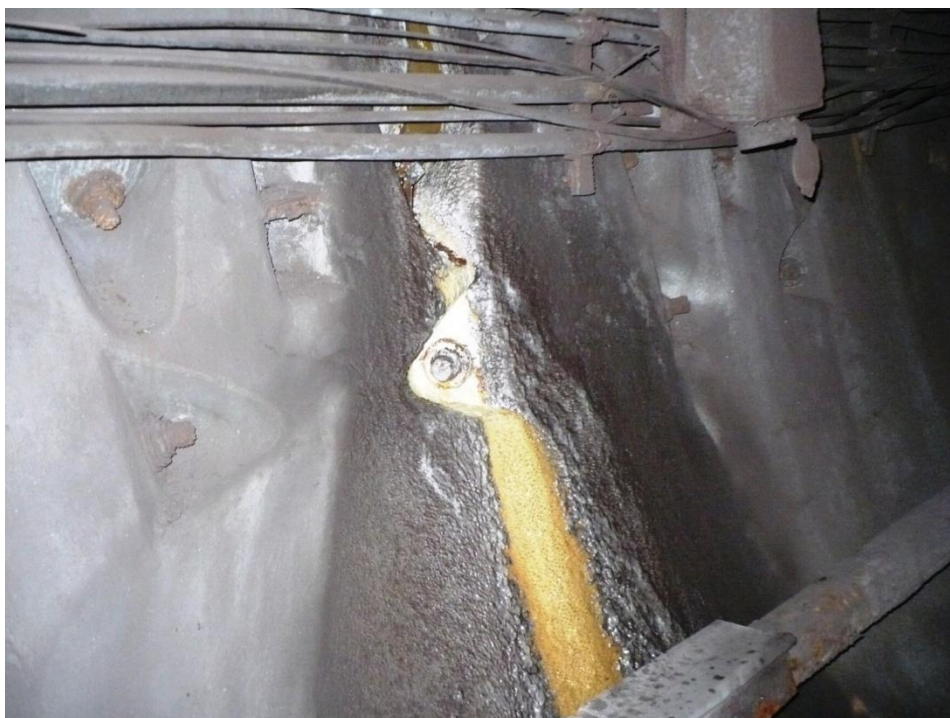
Infiltrații prin rostul transversal dintre bolțari, la inelul 1720, cu aport de nisip. Se etanșează cu rășină hidrostructurală cu vâscozitate redusă Fisură în conducta de incendiu, acoperită cu tablă, pentru protecția căii de rulare
