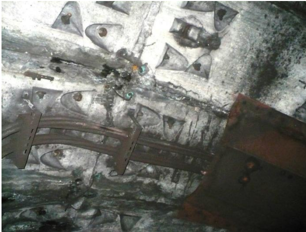
Infiltrații în boltă și pe lateral, la legătura inelului 1 cu peretele casetă al stației
