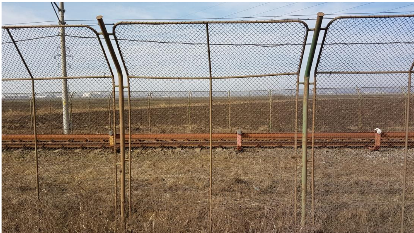
Fig.5.3.c.4.1.a - Situația existentă la cale de rulare - vedere in-situ
