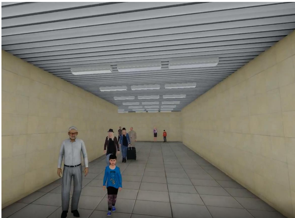
Fig. 5.3.c.6.17 - Vedere arhitectură interioară la stația Berceni-Centură - zonă pasaj subtraversare șoseaua Berceni
