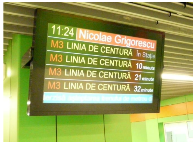
Panou de informare la nivel vestibul
