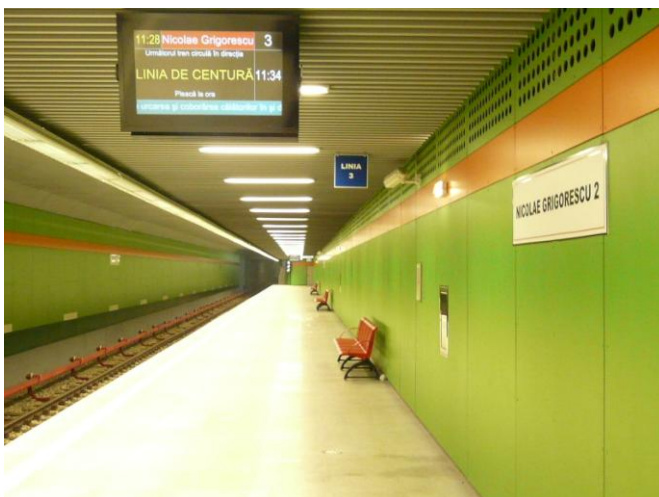
Panou de informare la nivel peron
